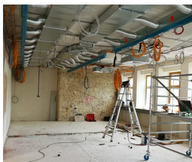
Lehrsaal in Kastl während der Renovierung
